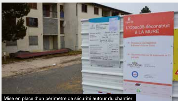
Mise en place d'un périmètre de sécurité autour du chantier
