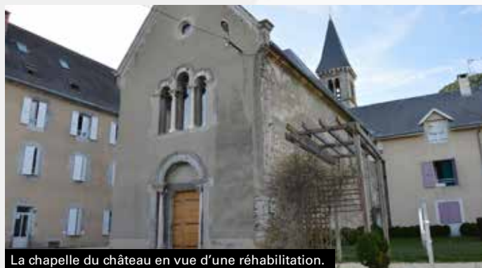
La chapelle du château en vue d'une réhabilitation.
