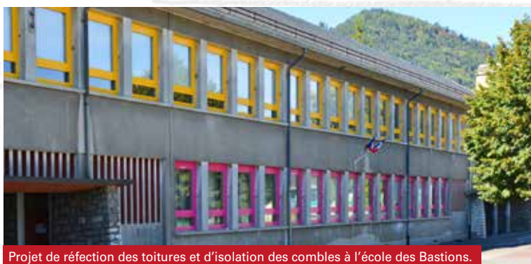
Projet de réfection des toitures et d'isolation des combles à l'école des Bastions.
