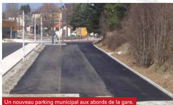
Un nouveau parking municipal aux abords de la gare.
