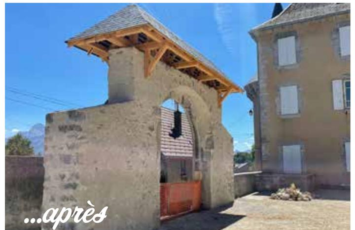
Les travaux ont consisté à remailler toute la maçonnerie de pierre en consolidant la voûte de façon à rouvrir l'embrasure, et à couvrir l'ensemble par un toit à quatre pans, couvert d'ardoises comme le montrent les photos anciennes.
