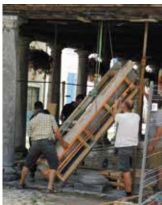
Remise en place du pilier de la halle.
