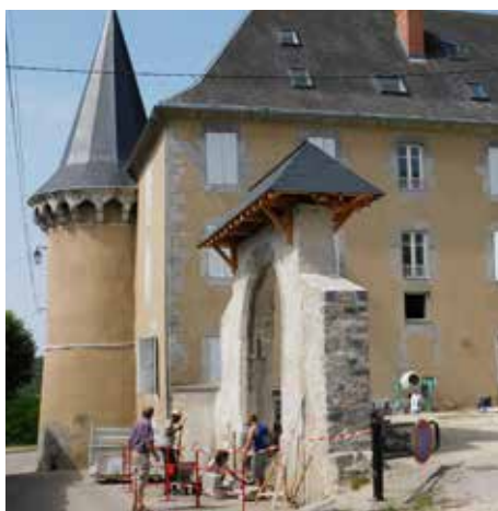
Réalisation d'un escalier sous le porche du château.
