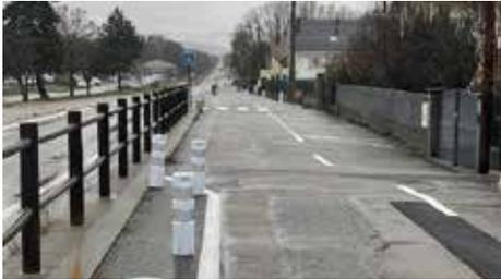
Aménagements dans la contre-allée du lieu-dit « Les Marais » le long de la RN 85, avenue du 22 août 1944... afin de réduire la vitesse des véhicules. Pose de quilles pour création de chicanes et réduction de la largeur de la voie – marquage au sol pour matérialisation du stationnement – réalisation d'un quai-bus PMR.
