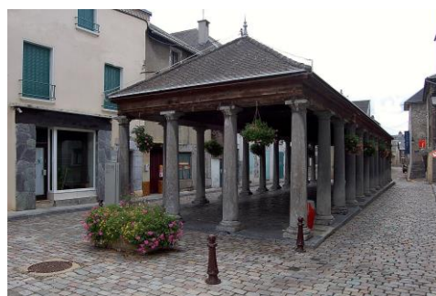
Rénovation de la halle
